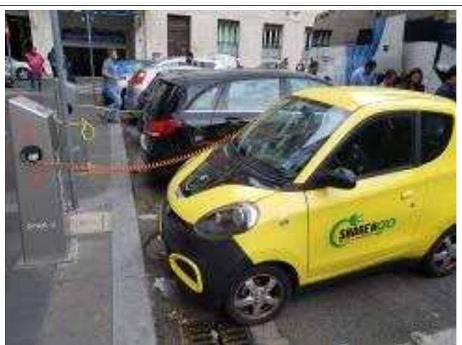
노외주차장 전기충전소 사진
