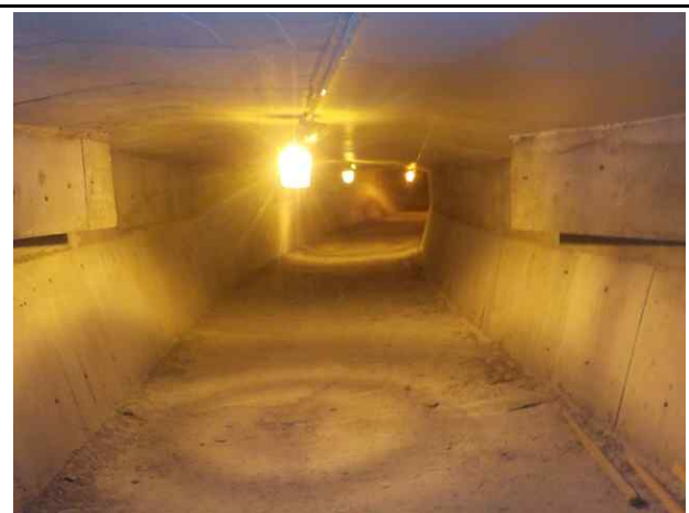
Ramp I 거더 내부 전경
