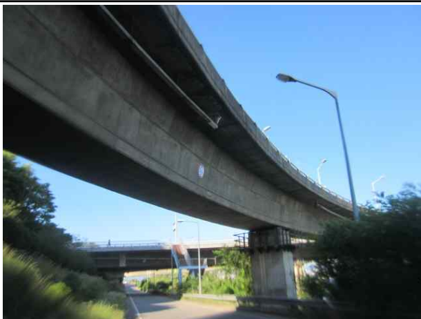
Ramp B 전경
