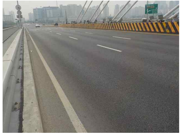
본교 교면포장 전경
