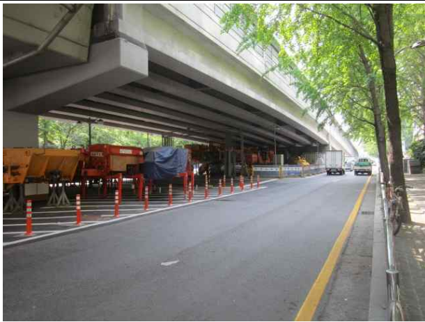
접속교 하부 전경
