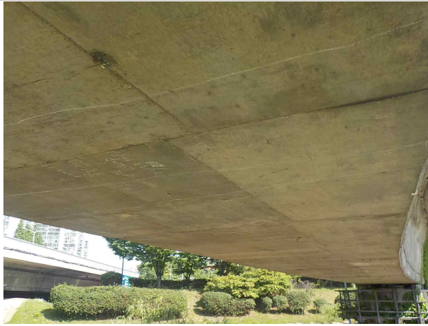
Ramp E 전경
