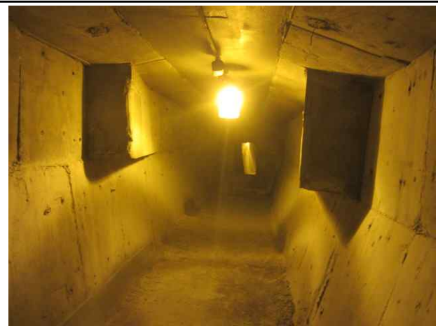
Ramp H 거더 내부 전경
