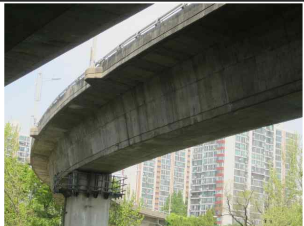
Ramp C 전경
