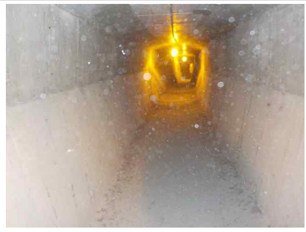
Ramp E 거더 내부 전경
