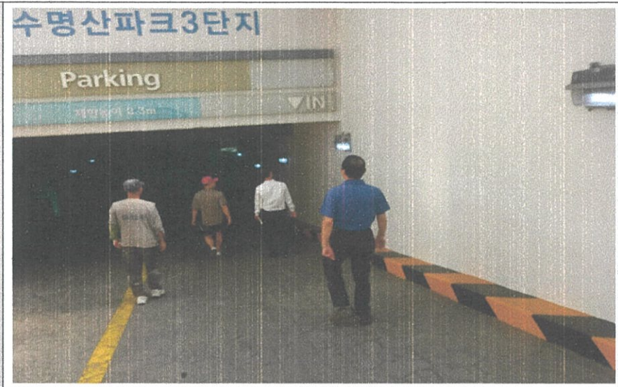
지하 주차장 도장 공사
