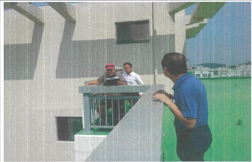
외벽 도장 공사 검사
