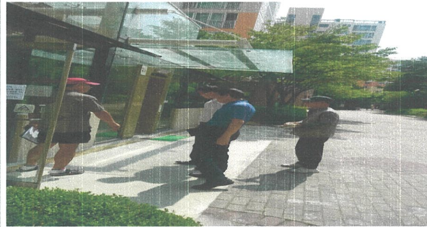
지하주차장 엘리베이터 1층 앞 3곳 우레탄 검사
