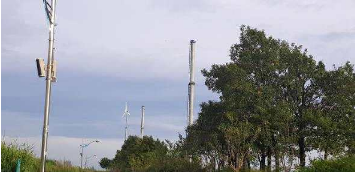
풍력발전기 1호기, 2호기 철거 완료
