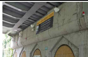
청계천 비우당교 경보설비 설치 : 씨이렌(우안) 1개, 경광등(좌·우안) 각 4개
