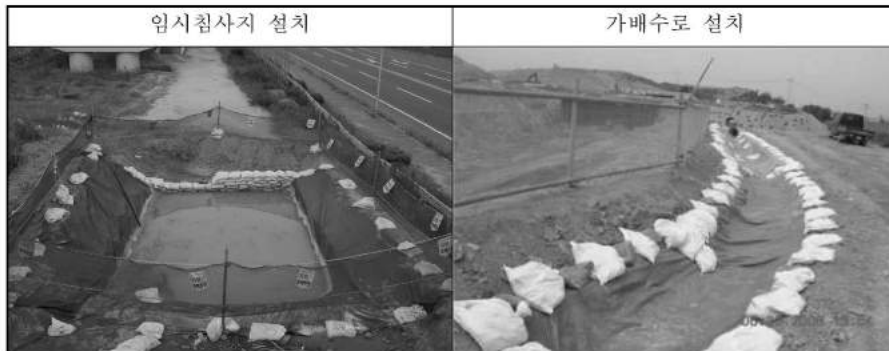
(그림 6.3.1-13) 공사시 호우재해 저감대책 설치사례
