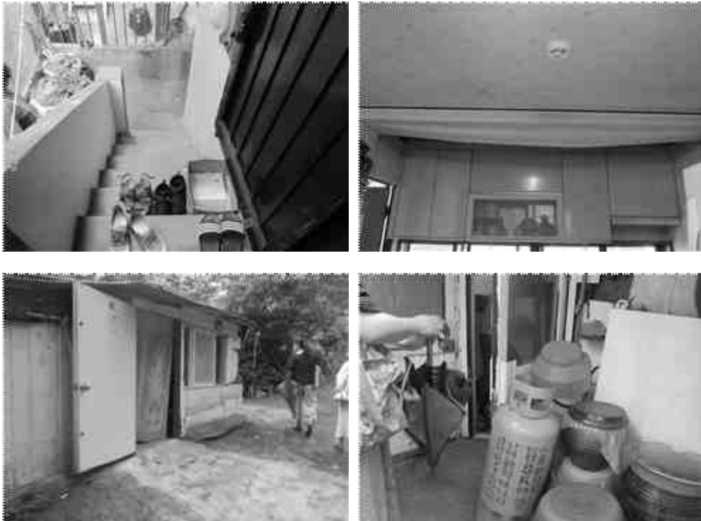
[그림-18] 현관, 무너진 천정, 가건물 주거, 가스안전 문제
