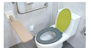
안전손잡이가 설치된 화장실
