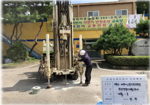
<그림 11> 토양개황조사 시료채취 전경 1
