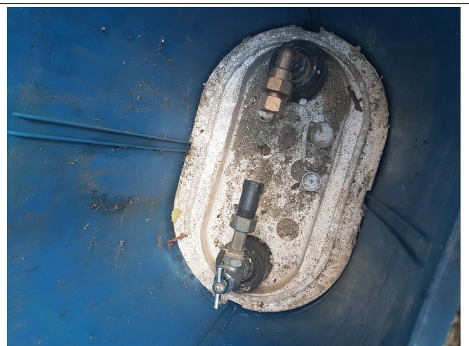
조치결과 : 플러그 설치
