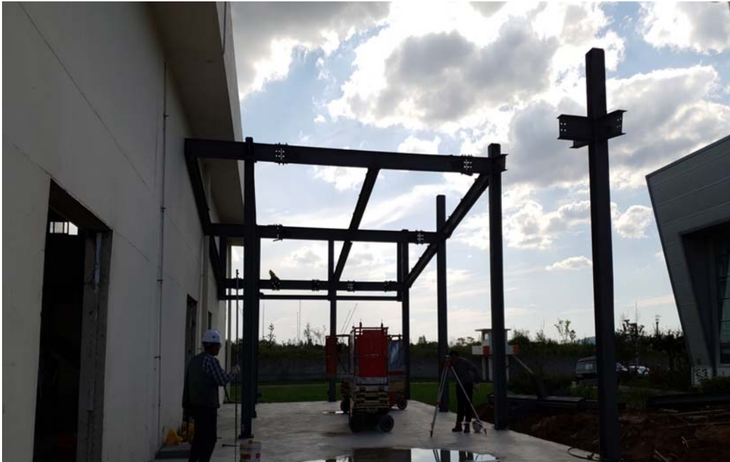
현장사진 8 - 증축부분 철골세우기 2
