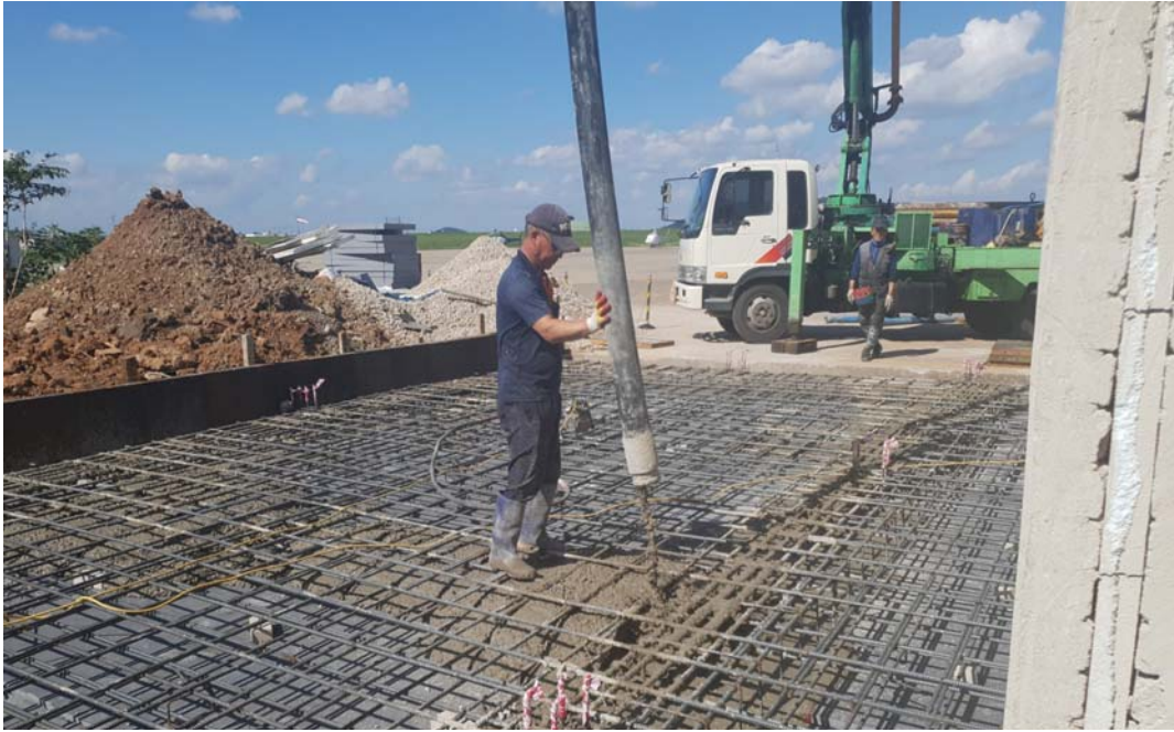
현장사진 6 - 증축부분 기초 콘크리트타설 2
