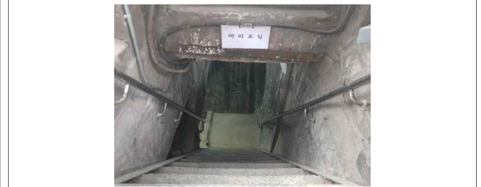
출입구 내부 계단 전경
