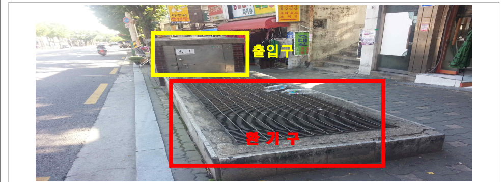
출입구 및 환기구 전경
