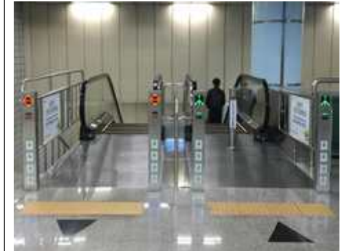
에스컬레이터 교체 후(상부측) (자동운전장치 설치)
