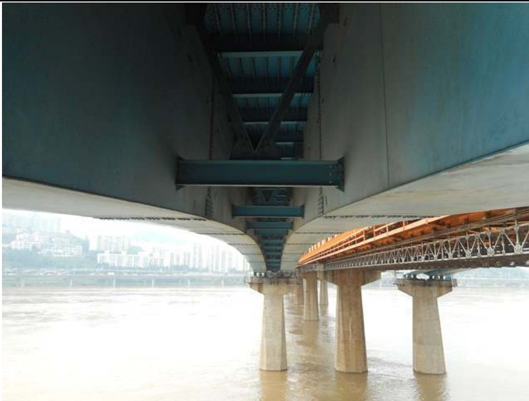
동호대교 본선 강바닥판거더 구간
