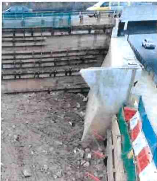
<A1 기존교대 전경>
