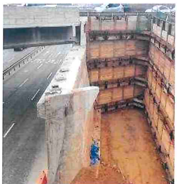
<A2 기존교대 전경>
