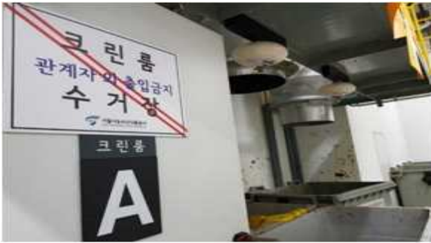
[클린룸 확산소화기 설치(18.1.24.)]
