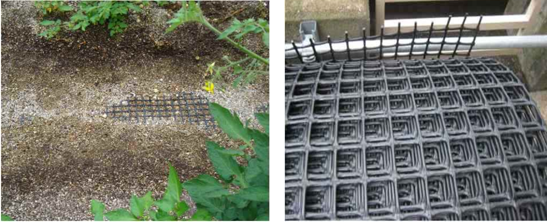
그림 8 농기구로부터 방수, 방근층을 보호하기 위해 보호층을 설치한 사례
