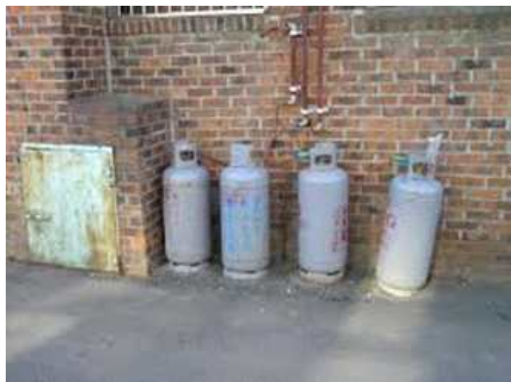
<그림 1-5> 서울시 LPG 용기 보관함 설치사례 및 건물 담벼락에 설치된 20kg 용기
