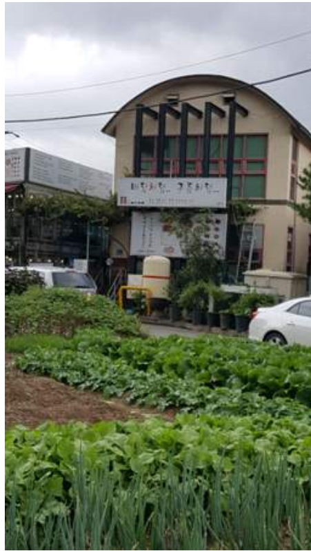
<그림 1-6> 집 근처, 공터, 건물과 건물 사이 등에 설치한 LPG 소형저장탱크 사례
