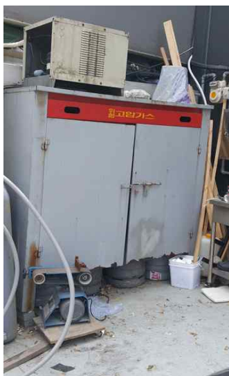
<그림 1-5> 서울시 LPG 용기 보관함 설치사례 및 건물 담벼락에 설치된 20kg 용기
