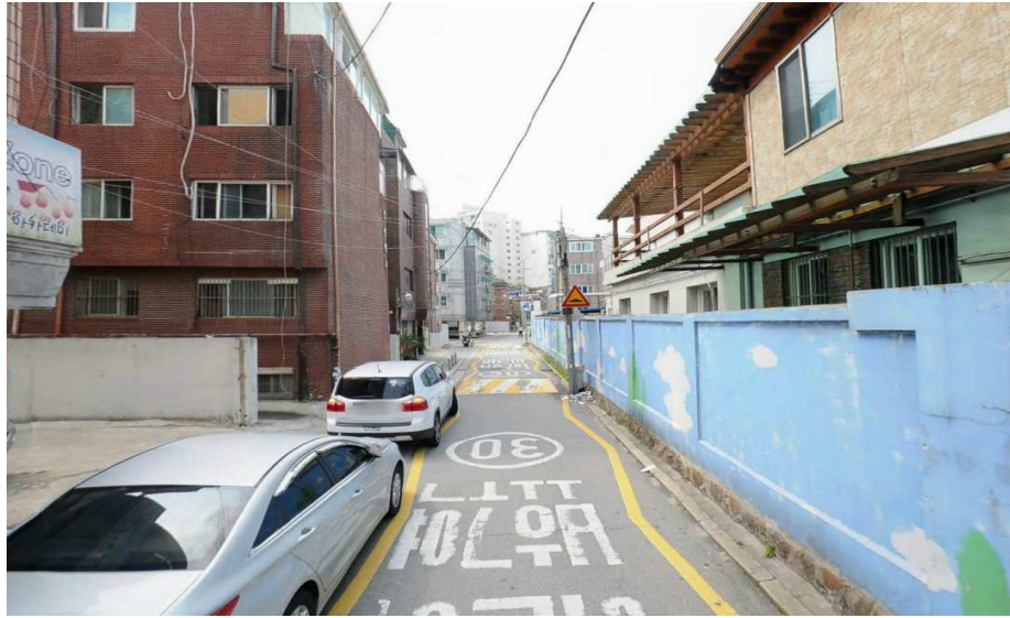
공 종 | 공사전 사진
