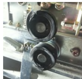
밴간격 부적합에 따른 롤러 파손
