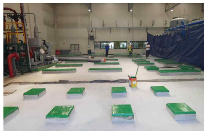
<기존 전처리 설비 철거(완료)>
