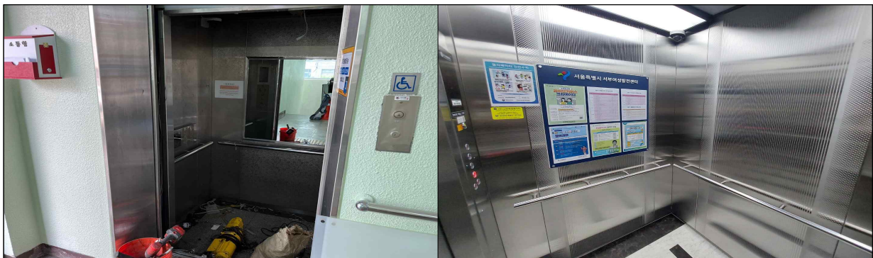
엘리베이터 전면 교체 공사(1) 22.04~22.06
