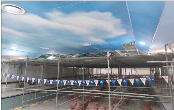
수영장 천장 보수 공사(1) 22.04~22.06
