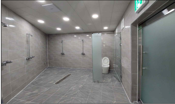
남성이용시설 신축 공사(1) 22.05~22.06
