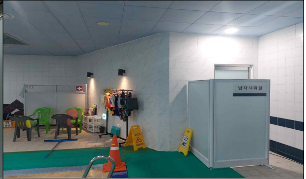
남성이용시설 신축 공사(2) 22.05~22.06
