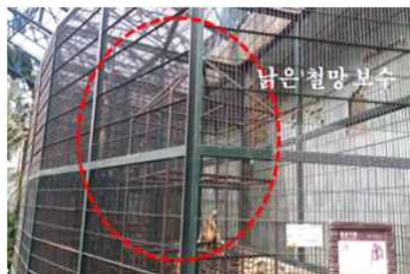
시설개선(남은 철망 보수)
