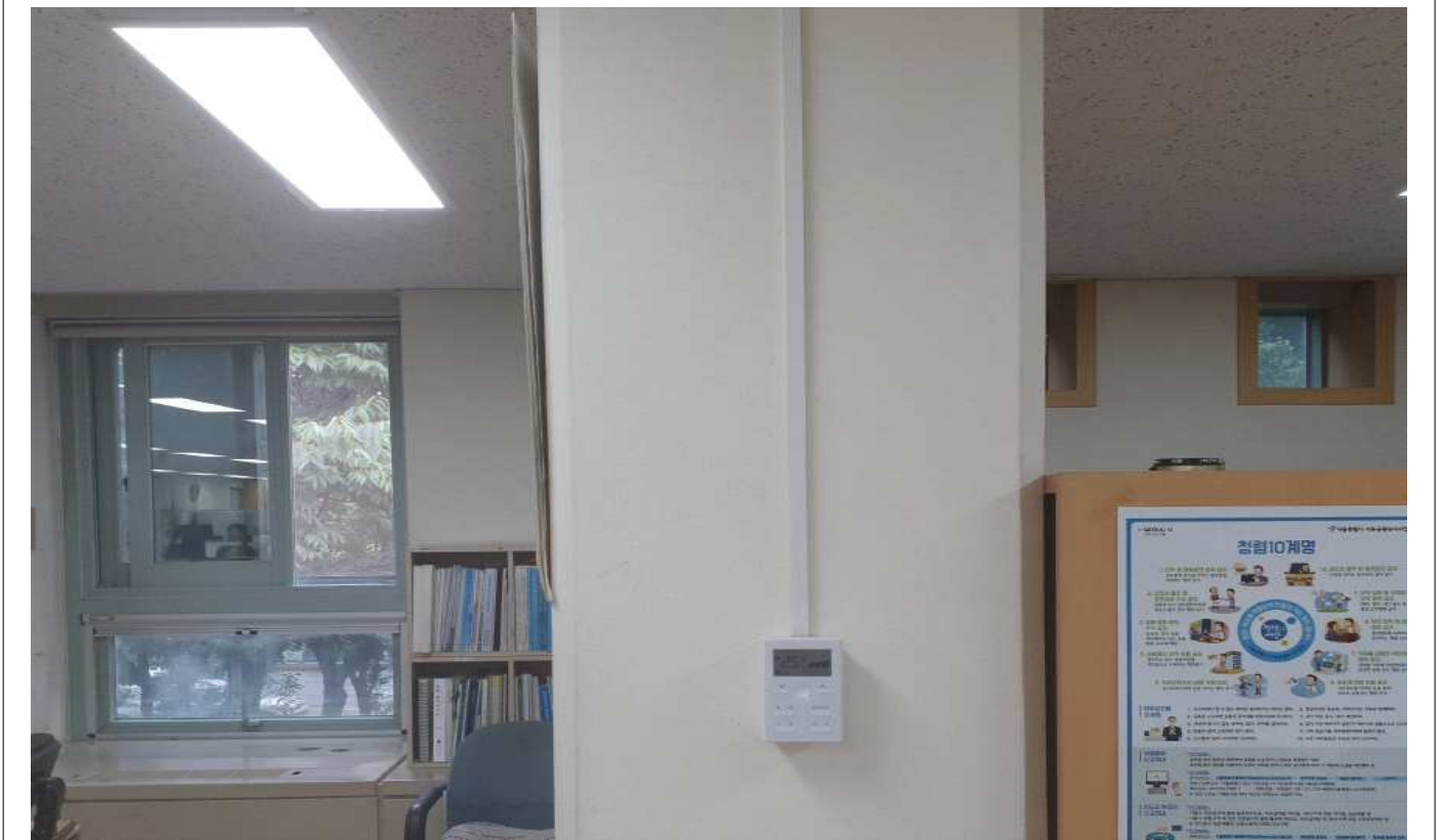
제어리모컨 설치 및 배관
