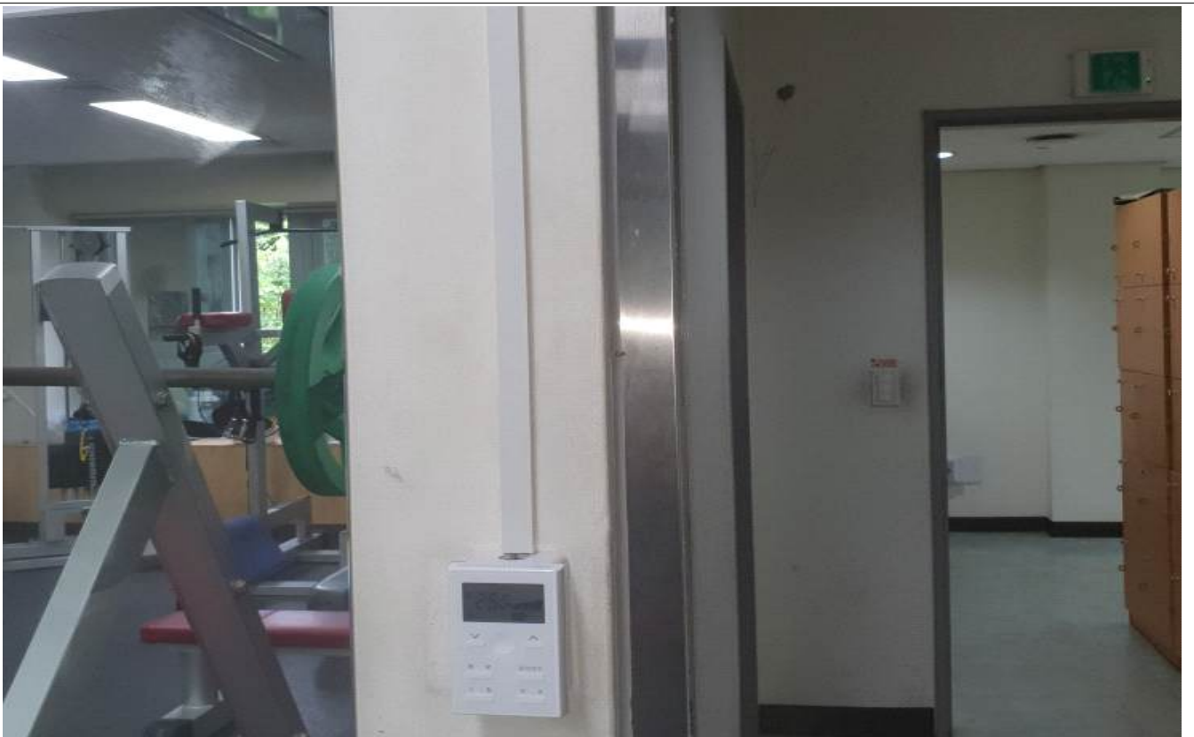
제어리모컨 설치 및 배관
