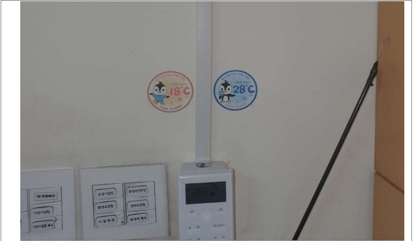
제어리모컨 설치 및 배관
