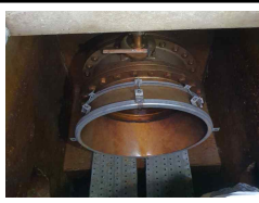
고정용 앵글 설치
