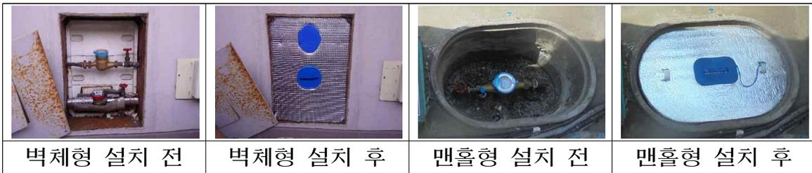
벽체형 설치 전      벽체형 설치 후      맨홀형 설치 전      맨홀형 설치 후
