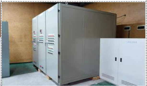
종로구 사직터널 배전반 3면 교체 후
