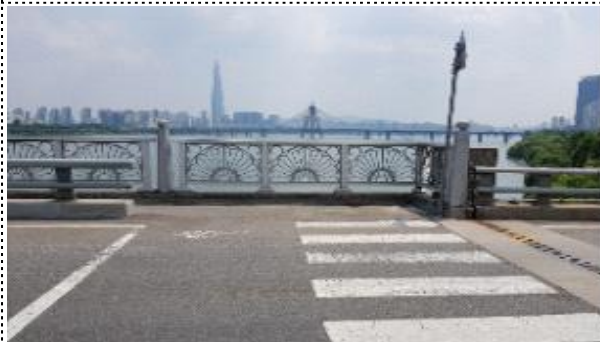
강동구 천호대교 북단 교통신호기 설치 전
