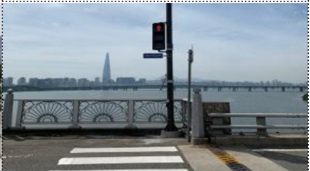
강동구 천호대교 북단 교통신호기 설치 후
