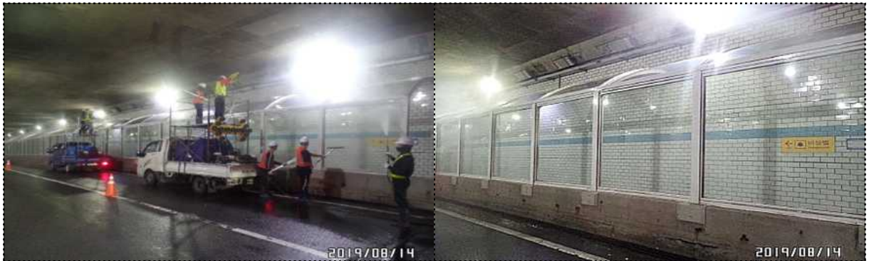
금천구 호암로 호암1터널 방음벽 세척
