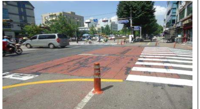
2.백제고분로275호앞(차도상황단보도도색탈색및차선미도색, 차도상복공판미끄럼방지노면 미설치)
