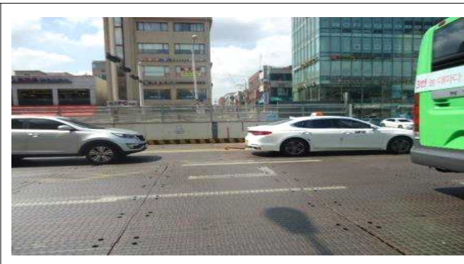
3.백제고분로203호앞(차도상황단보도도색탈색 및 차도상복공판미끄럼방지 미도포)-횡단보도 앞 2m
