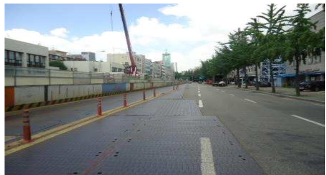
7.백제고분로161호앞(차도상 횡단보도 도색탈색 및 차도상복공판 미끄럼방지 미도포)- 횡단보도앞 20m
