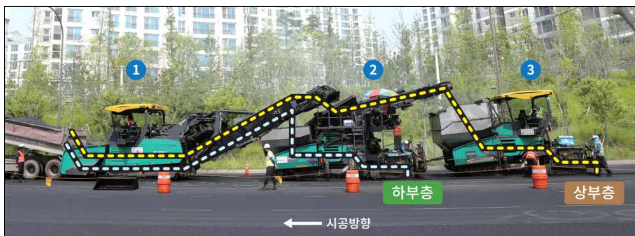
< 복층포설전용장비(In-Line Pave)를 이용한 상·하부층 동시포장 >
