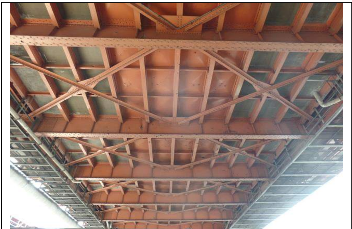
아치교 바닥판 하면 전경 (구교)
