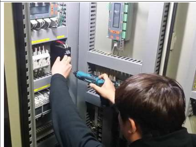
SMPS(교류·직류 변환장치) 교체 사진
