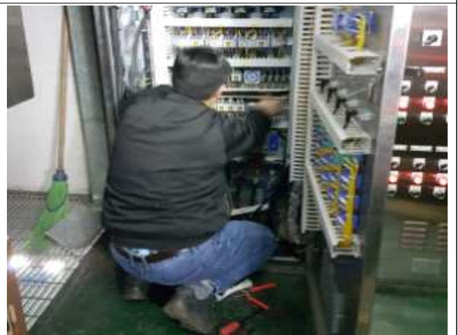
SMPS(교류·직류 변환장치) 교체 사진
