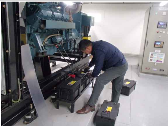
비상발전기 배터리 교체 사진
