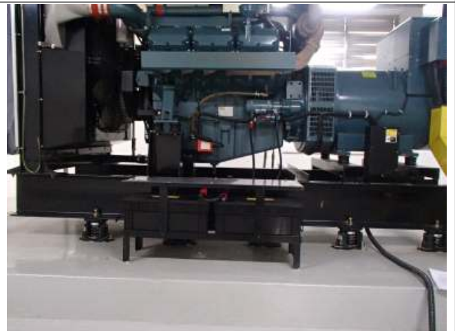
비상발전기 배터리 교체 사진
