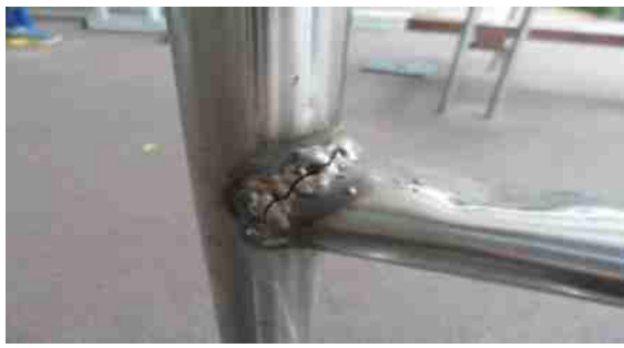
운동시설 교체(역기 파손)
