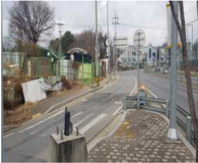
<47번국도~북부간선도로 연결 램프>
