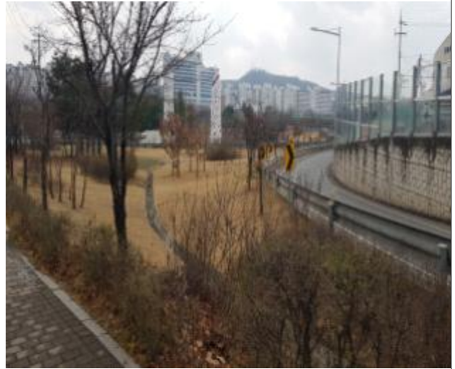
<47번국도~북부간선도로 연결 램프>
