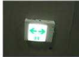
▲ 통로유도등이 올바르게 설치된 경우
