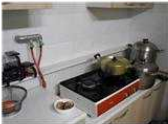
▲ 가스누설경보기가 미설치된 경우
