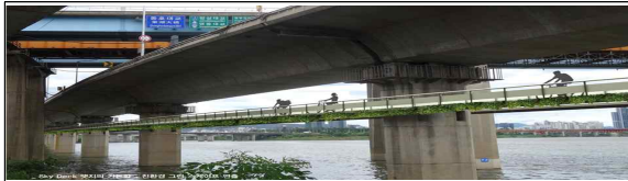
기존 고가도로 및 교량 측·하면 데크 조성
