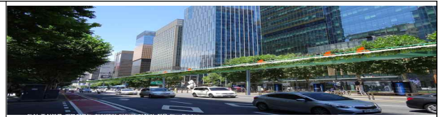
입체구조물 신규 설치
