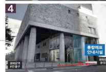
외부 통합매표·안내시설 설치
