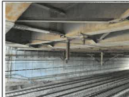
연번5-1: 교량 하부 점검
