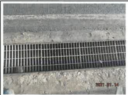
연번3-3: 배수로 점검
