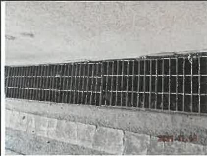
연번2-3: 배수로 점검
