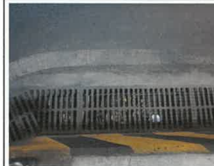
연번4-3: 배수로 점검
