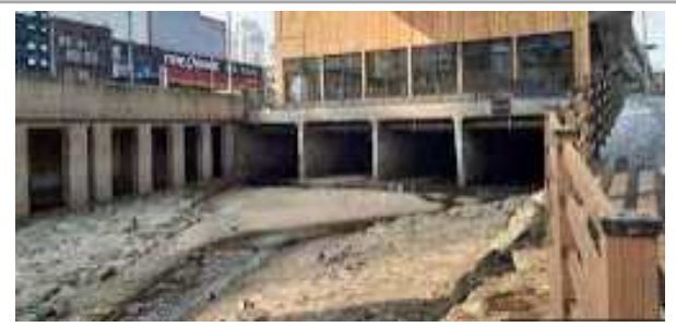
[정릉천] 유지용수 공급관로 설치
