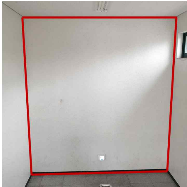
강당(실내체육관) 2~3층 사이 벽면
