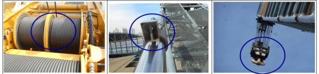
4. 풀 로이스트 와이어로프 상태 양호
