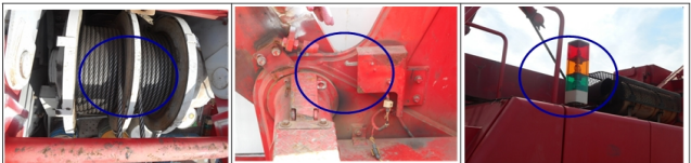
4. 풀 로이스트 와이어로프 상태 양호
