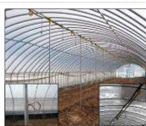
<원예시설 보강지주 설치>
