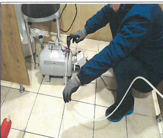
별관 화장실 배수라인 해빙작업
