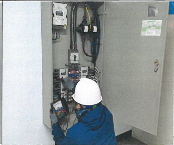
분전반 절연저항 측정
