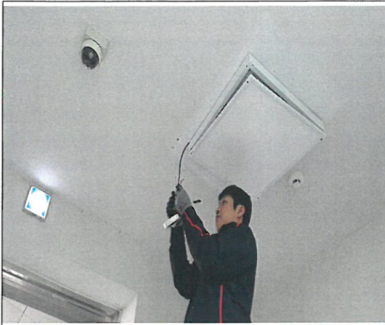
별관 1층 홀 전등센서 설치
