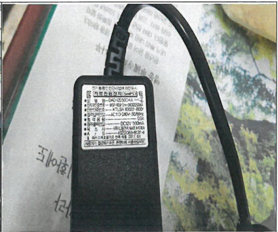
CCTV 카메라 전원공급장치 교체
