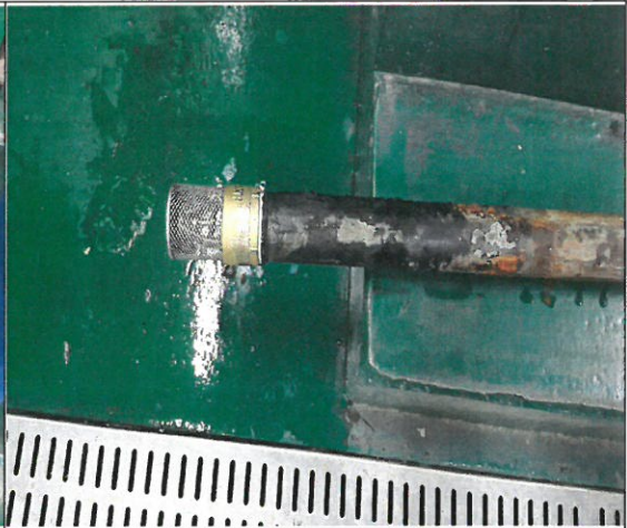
집수정펌프 후드밸브 교체 후
