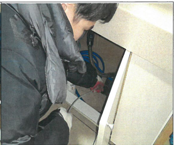
별관 화장실 배수라인 해빙작업
