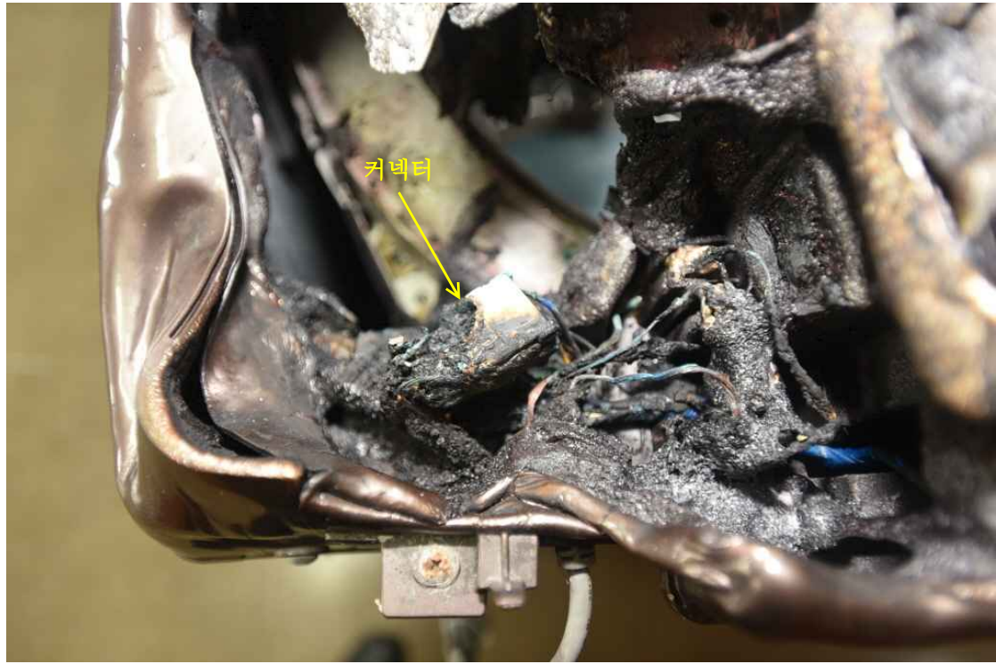
사진 19 모서리 내부 소실 상태 촬영날짜 '17. 8. 25.
