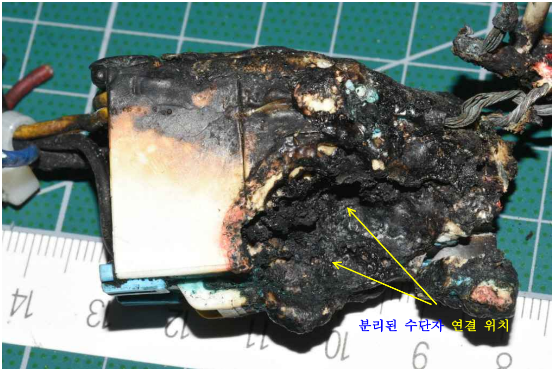
사진 24 커넥터 소실 상태 촬영날짜 '17. 8. 25.
