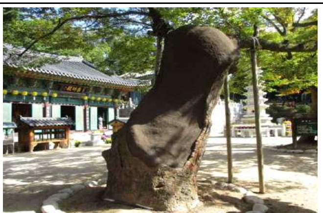
외과수술, 지지대 설치, 호박돌 경계설치(서18-6)
