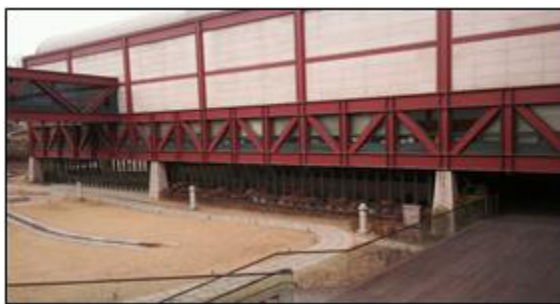
〈정비전 - 2층 사무실 유리창 차폐〉
