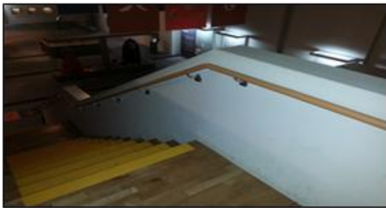
〈상설전시실 1존 핸드레일 설치〉
