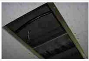
콘크리트 부식에 따른 철근 노출 (마감재 외부 및 내부)
