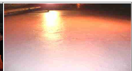
콘크리트 보수 완료
