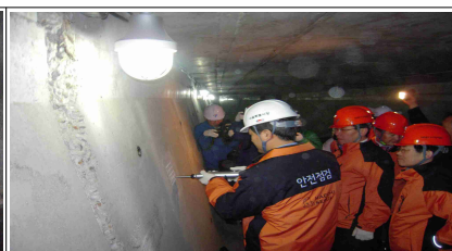
콘크리트 강도 측정
