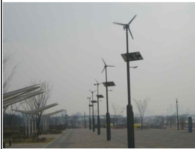
[사진 4] 가로등설치 (태양광+풍력) 설치현황
