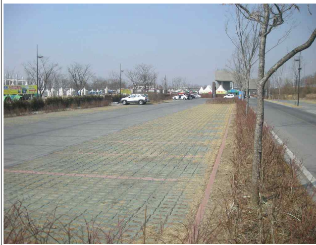
[사진 5] 투수성포장 시공현황
