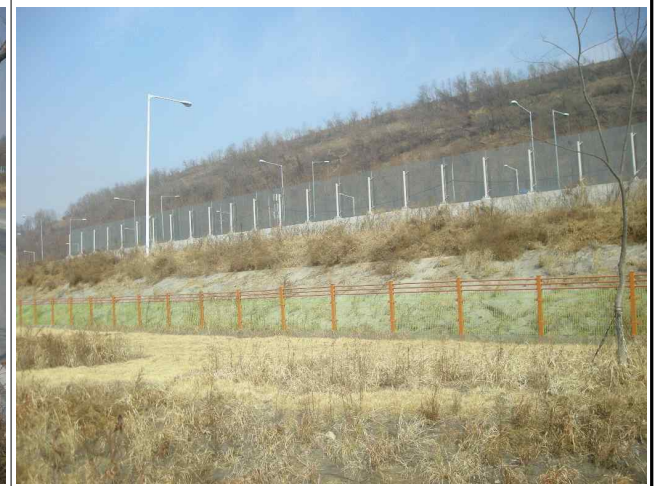
[사진 6] 방음벽 (강변북로변 캠핑장 소음저감시설)
