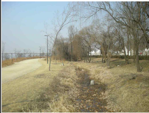
[사진 7] 생태수로 시공현황
