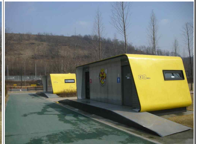
[사진 12] 화장실 설치현황
