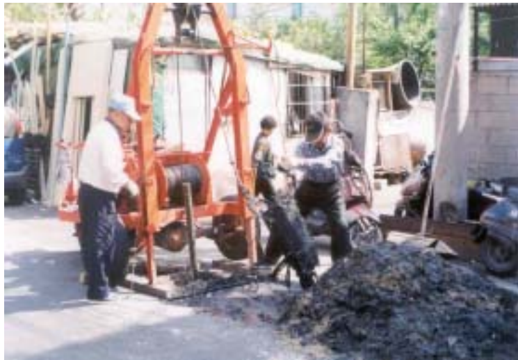
<사진 2.11> 바켓 속의 준설토를 맨홀 주위에 쌓아 놓는 모습(준설작업④)
