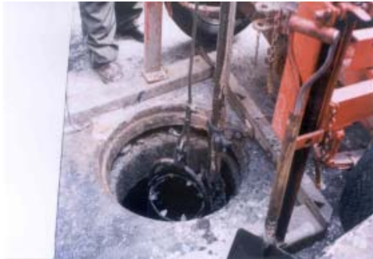
<사진 2.9> 준설기를 이용하여 하수관거내의 준설토를 바켓이 퍼올리는 모습(준설작업④)
