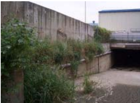
<사진 4.31> 외벽에 설치되어 있는 준설토오수 배수관 모습
