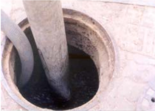
<사진 2.19> 분사기와 흡입기가 같이 맨홀에 설치되어 있는 모습과 분사기가 물을 분사하는 모습(세정② 및 흡입작업④)
