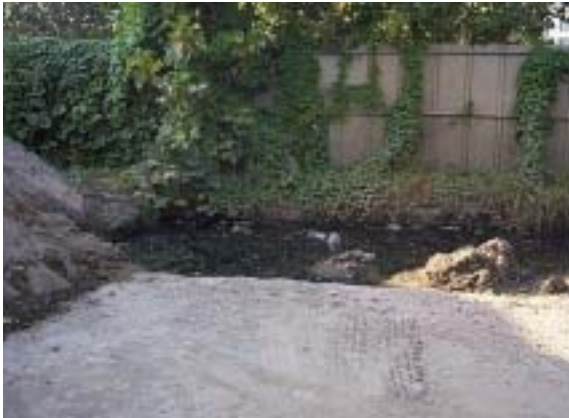
<사진 4.8> 흡입준설토의 함수량을 줄이기 위해 설 치해 놓은 침사지 모습
