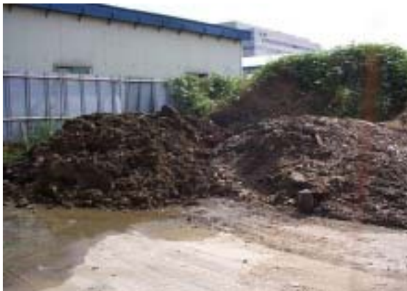
<사진 4.1> 바켓준설토와 흡입준설토를 구분하여 적하해 놓은 모습 (바켓준설토는 왼쪽에, 흡입준설토는 오른쪽에 적하되어 있음)
