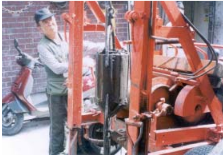
<사진 2.10> 하수관거의 준설토를 바켓이 피내어 맨홀 밖으로 올라오는 모습(준설작업④)
