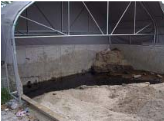
<사진 4.40> 흡입준설토 적하시설에 설치되어 있는 지붕과 준설토에서 발생된 오수가 배제되지 못하고 고여있는 모습
