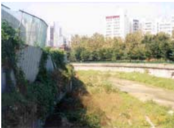
<사진 4.33> 목동천 옆에 설치되어 있는 중간적치장 모습과 철재외벽 및 아파트단지
