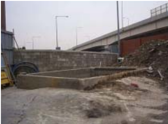
<사진 4.16> 준설토의 함수량을 줄이기 위해 설치해 놓은 침사지 (침사지에서 물을 뺀 후에 옆으로 옮겨 건조시킴)
