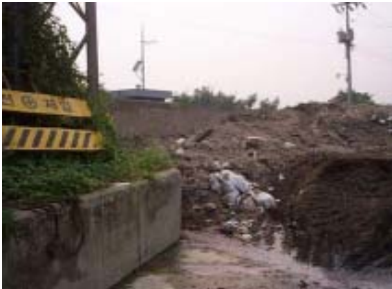
<사진 4.18> 중간적치장 공간이 협소하여 직영과 민영을 구분하지 않고 준설토를 적하해 놓은 모습
