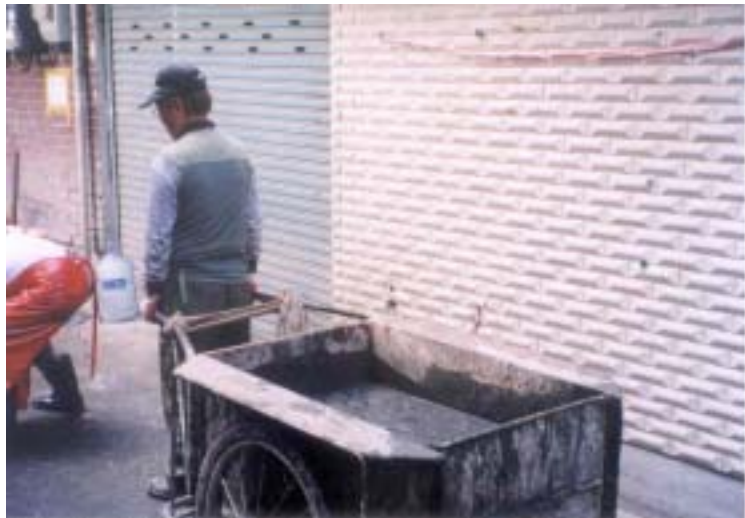
<사진 2.13> 좁은 장소의 준설토를 덤프트럭이 있는 도로로 운반하는 인력상차 모습(준설토 수거㉞)
