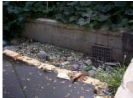
<사진 4.2> 준설토의 함수량을 줄이기 위하여 설치해 놓은 침사지(좌)와 오수를 하수관으로 배출하는 배수시설(우)
