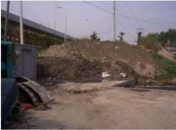
<사진 4.27> 장소가 협소하여 직영과 민영을 구분하지 않고 적하해 놓은 준설토 모습
