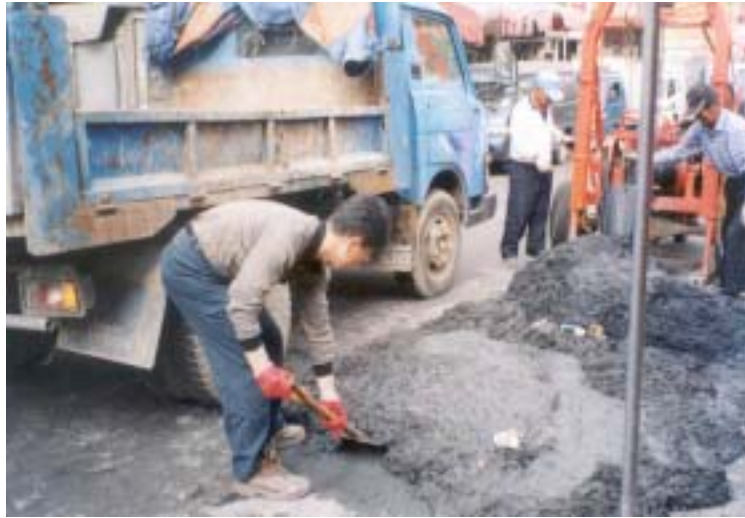
<사진 2.12> 준설토를 중간적치장으로 운반하기 위하여 덤프트럭으로 수거하는 모습(준설토 수거㉞)
