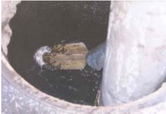
<사진 2.17> 물의 분사압력을 이용하여 관거내 퇴적물을 맨홀로 끌어내기 위하여 분사기를 하수관으로 주입하는 모습(세정작업②)
