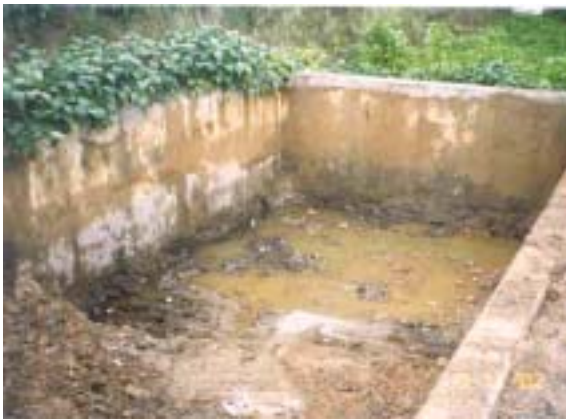
<사진 4.42> 준설토에서 발생한 오수가 침사지에 고여있는 모습
