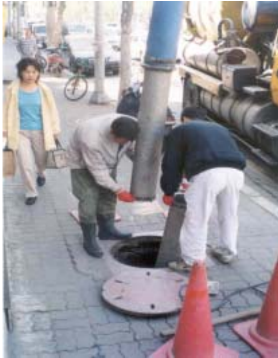
<사진 2.18> 분사기에 의하여 맨홀에 유입된 퇴적토를 흡입탱크에 집적시키기 위하여 맨홀에 흡입기를 넣는 모습(흡입작업④)
