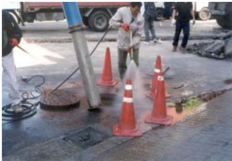
<사진 2.21> 흡입준설 완료 후의 시설정리 및 장소주변 청소모습(시설정리 및 장소주변 청소㉕)
