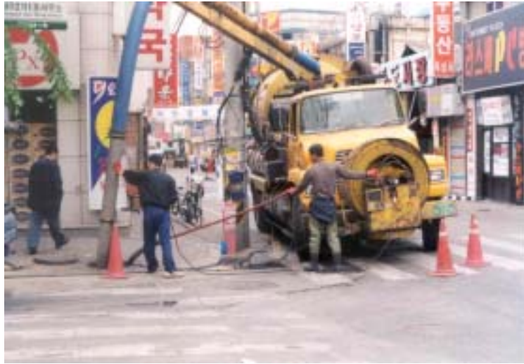
<사진 2.20> 세정과 흡입작업을 서로 반복하면서 준설하고 있는 모습(세정㉔ 및 흡입작업㉔)
