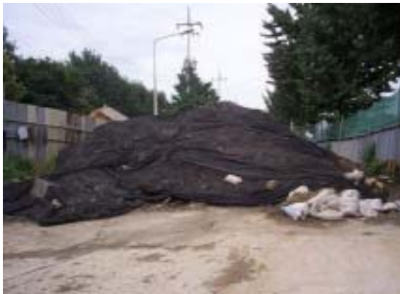
<사진 4.10> 분리적하된 흡입준설토에 지붕대신으로 망사덮개로 덮어놓은 모습(강우시 빗물에 의한 유실방지)
