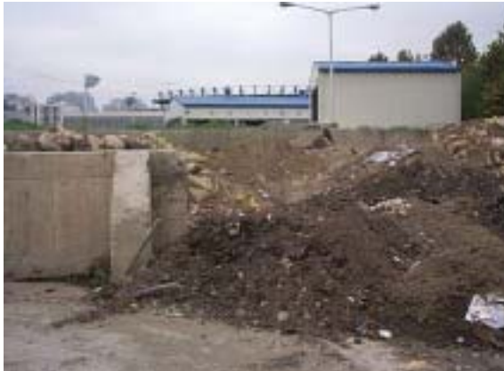
<사진 4.29> 바켓준설토와 암거준설토를 분리하기 위한 분리벽과 적하되어 있는 준설토의 모습
