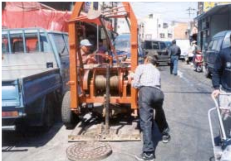
<사진 2.6> 준설토장소 양단의 맨홀에 바켓식 준설토기의 배치모습(작업준비①)
