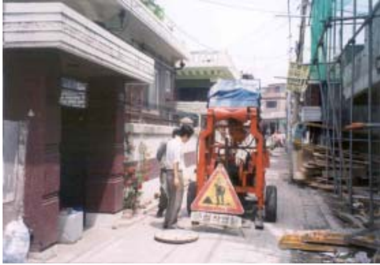
<사진 2.8> 양단의 맨홀에 바켓식 준설준비 완료상태(지지대 설치②)
