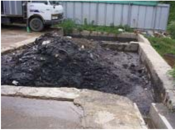
<사진 4.11> 준설토의 함수량을 줄이기 위해 침사지에 준설토를 넣은 모습과 침사지의 준설토오수를 하수관으로 배출하기 위한 배수시설
