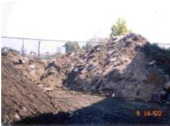
<사진 4.34> 바켓준설토와 흡입준설토를 구분하여 집하해 놓은 모습
