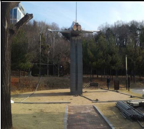
내 용 외줄비계 및 방진망 설치 전 01
