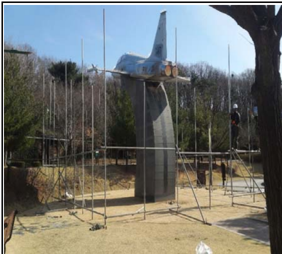
내 용 외줄비계 설치
