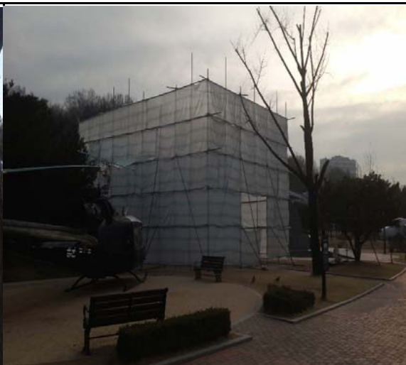
내 용 외줄비계 및 방진망 설치
