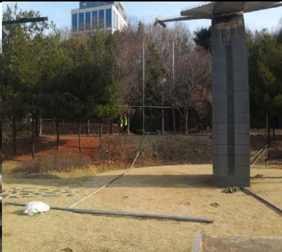
내 용 외줄비계 및 방진망 설치 전 02
