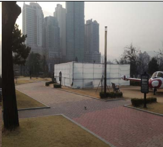
내 용 외줄비계 및 방진망 설치
